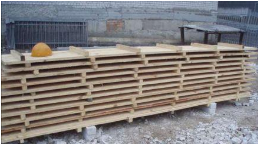
Рисунок 3.15- Щити розбірно-переставної опалубки
