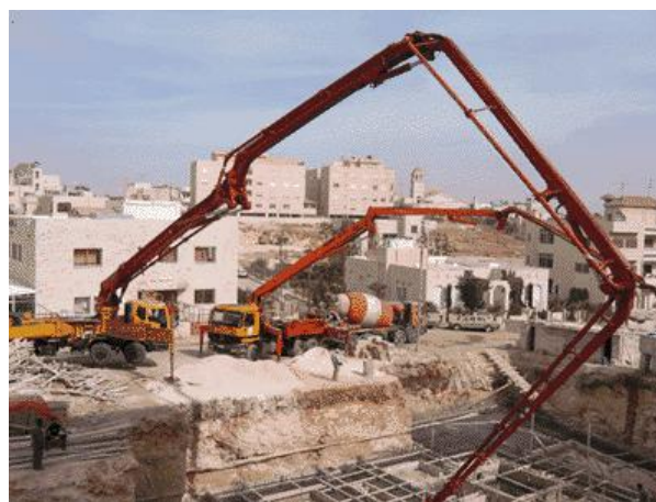
Рисунок 3.19 - Подача бетону в блоки бетонування
