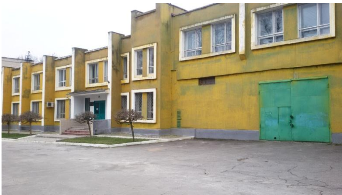
Рис. 1. Простір для паркування біля головного входу в будівлю
