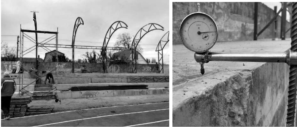
Рис. 1. Загальний вигляд решітчастих конструкцій та приладу для вимірювання переміщень
