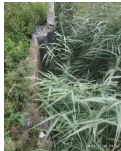
гідротехнічна споруда на каналі МК
