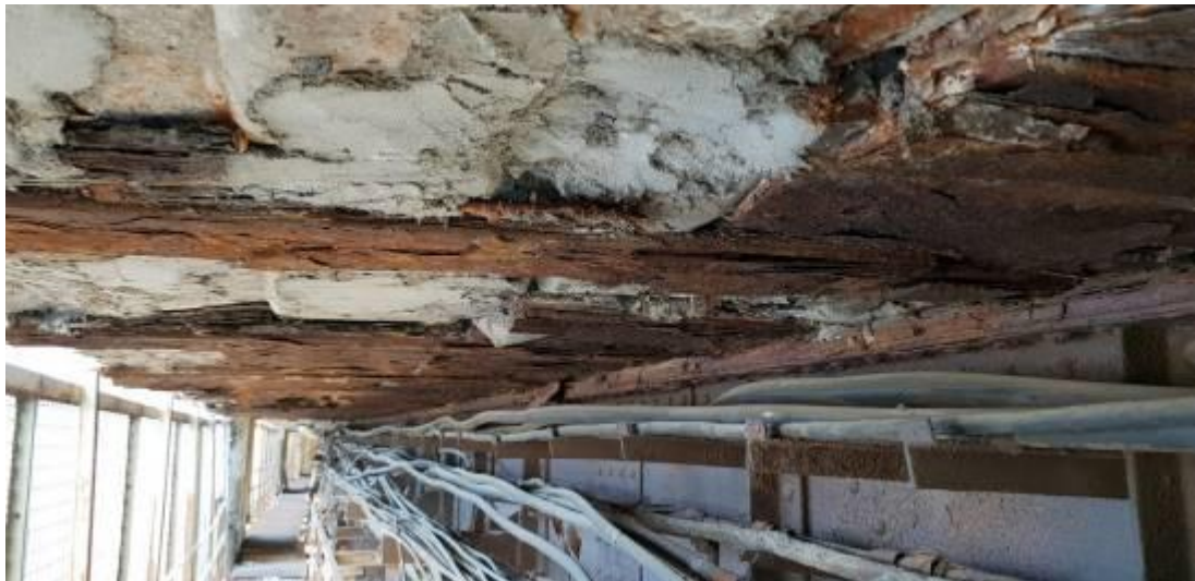
Рисунок 2 – Корозія сталевого профілю
