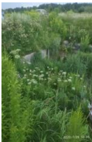
шлюз-регулятор на каналі ОК-2-1
