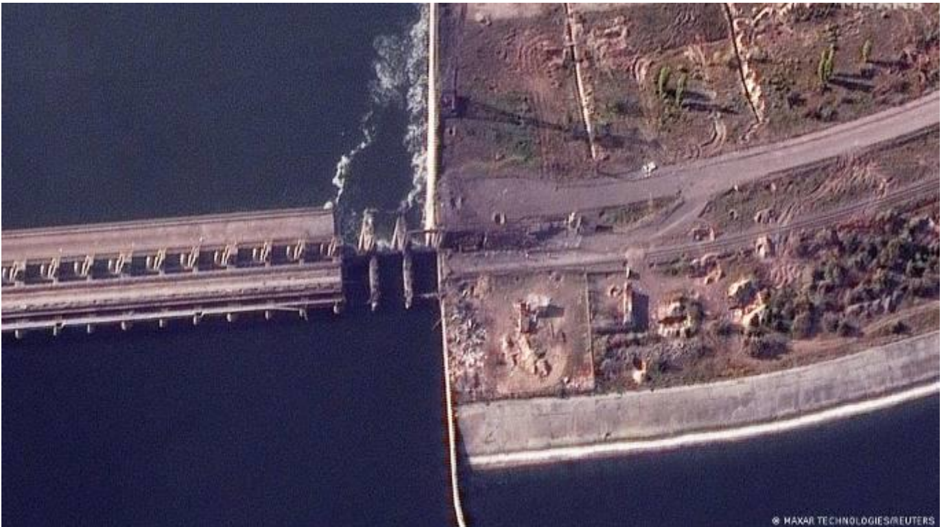
Рисунок 1- Супутниковий знімок демонструє пошкодження шлюзових воріт на дамбі Каховської ГЕС, листопад 2022
