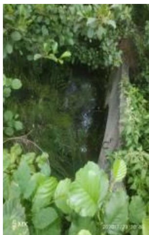
шлюз-регулятор на каналі ОК-1
