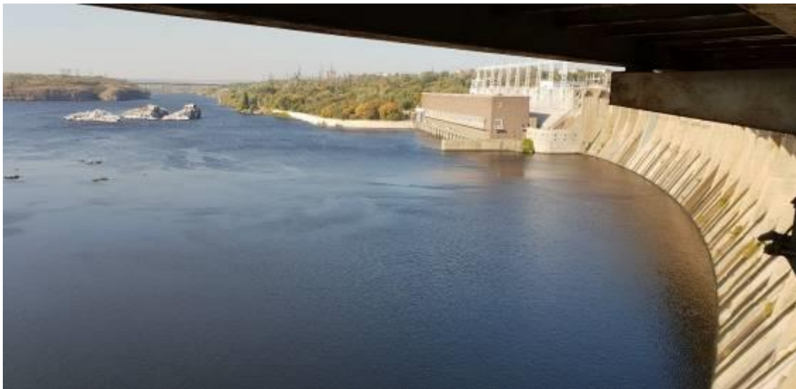
Рисунок 6 – Вид правобережної частини гідротехнічної споруди
