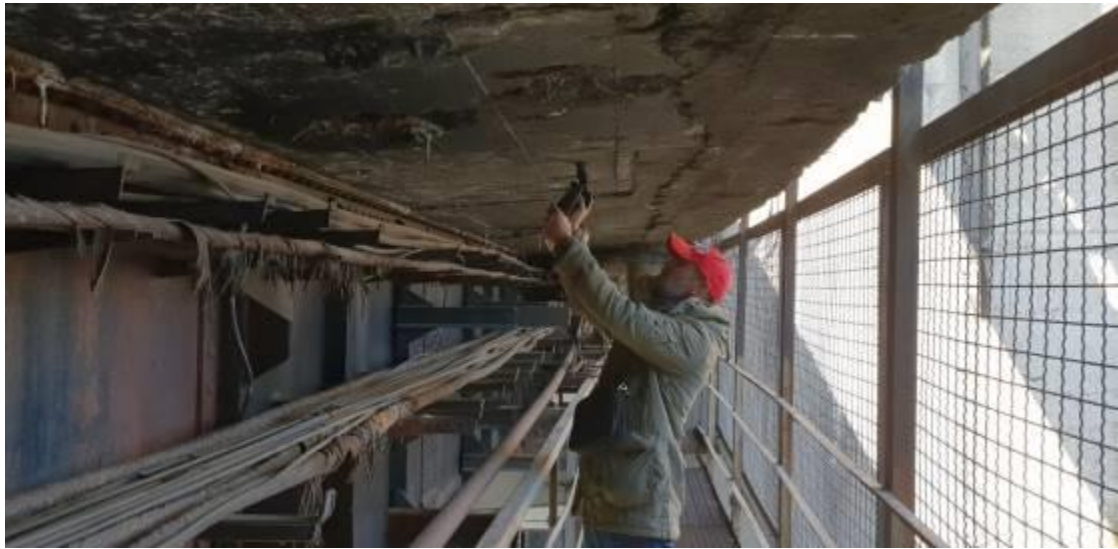
Рисунок 5 – Визначення залишкової міцності бетону
