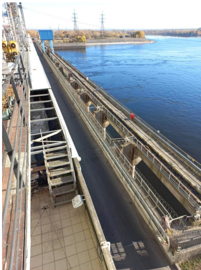
Рис. 1 - Загальний вигляд Канівської ГЕС
