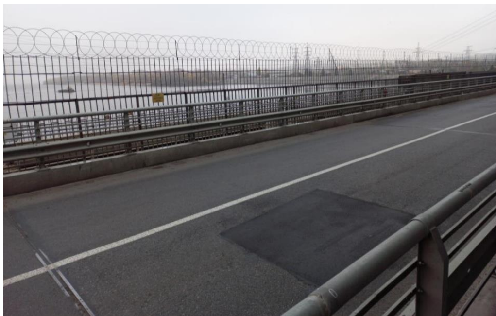
Рис. 2 - Вигляд проїзної частини. Виконано ямковий ремонт асфальтобетонного покриття проїзної частини прогін 0-1.
