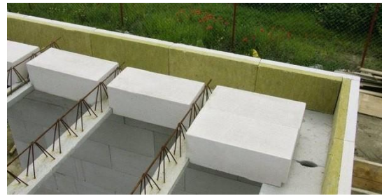
Рис. 1. Вид перекриття з Т-подібних блоків газобетону на балки
