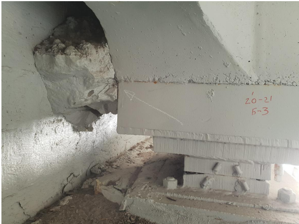
Рис.2. Не забезпечений зазор між торцем ребра балки Б-3 і опорою 20. Зазор частково заповнений бетоном. Обмежені переміщення, додаткові напруги
