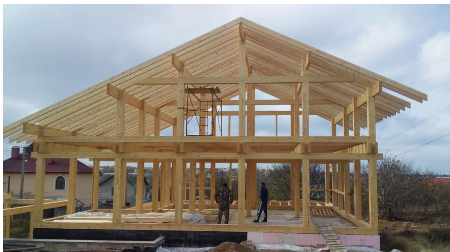
Рис. 3. Каркас сучасного будинку за технологією фахверк
